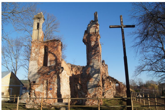
Il. 19. Mielnik. Ruiny kościoła Trójcy Świętej. Widok fasady (fot. J. Uścińowicz, 2017)
