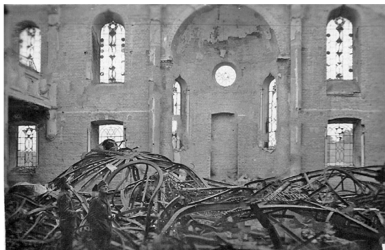
Il. 35. Wielka Synagoga w Białymstoku. Widok wnętrza w 1941 r. Na pierwszym planie zniszczona konstrukcja kopuły (fot. autor nieznany)
