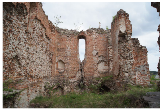
Il. 21. Mielnik. Ruiny kościoła Trójcy Świętej. Widok ściany wschodniej (fot. J. Uścińowicz, 2017)
