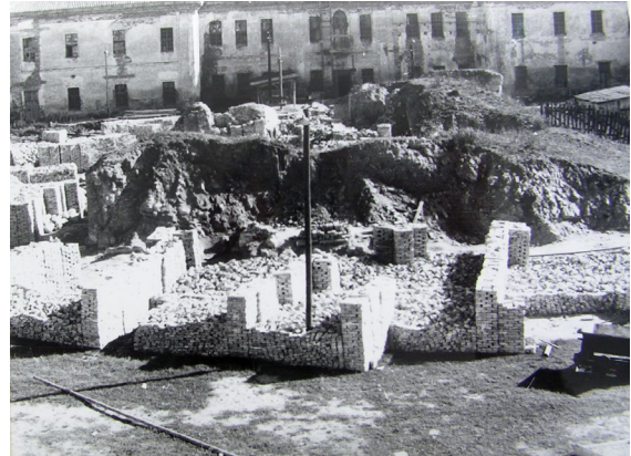
Il. 10. Supraśl. Ruiny cerkwi Zwiastowania Przenajświętszej Bogurodzicy podczas rozbiórki (fot. Wł. Paszkowski, 1949) V
