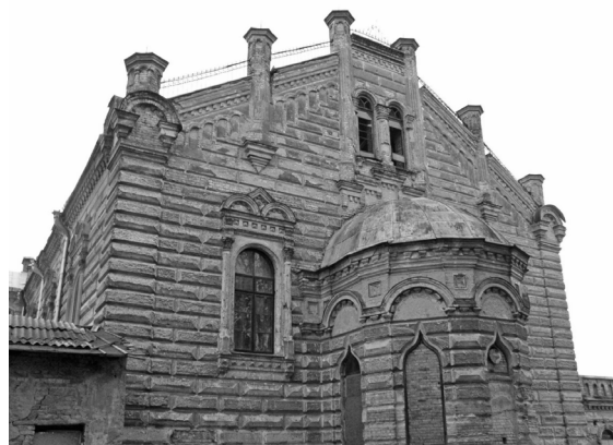
Il. 33. Wielka Synagoga Chóralna w Grodnie. Widok zewnętrzny części wschodniej w stanie obecnym (fot. autor)
