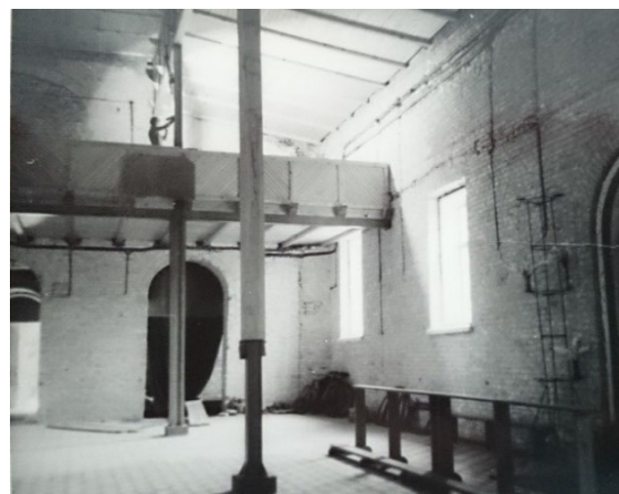
Il. 11. Widok wnętrza świątyni (w stronę chóru) w trakcie przebudowy w latach 60. XX w. IX
