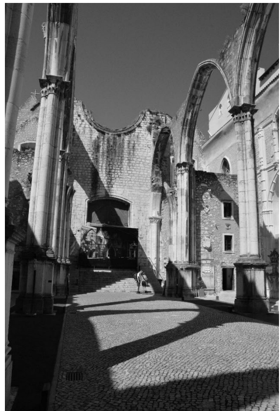
Il. 5. Widok nawy głównej (fot. autor)
