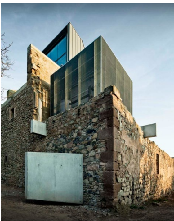
Il. 13. Kościół Sant Francesc w Santpedor. Nowe elementy (fot. Jordi Surroca) 13
