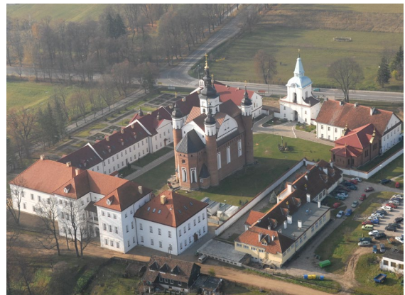
Il. 12. Supraśl. Monaster Zwiastowania Przenajświętszej Bogurodzicy. Widok zespołu z góry po rekonstrukcji (fot. P. Sawicki, 2011)
