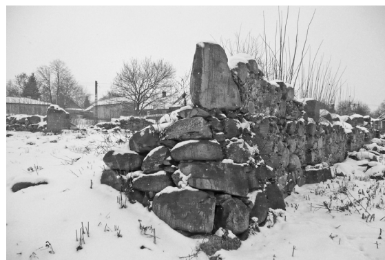
Il. 5. Ruiny Wielkiej Synagogi w Krynkach. Widok ruin w stanie obecnym (fot. autor)
