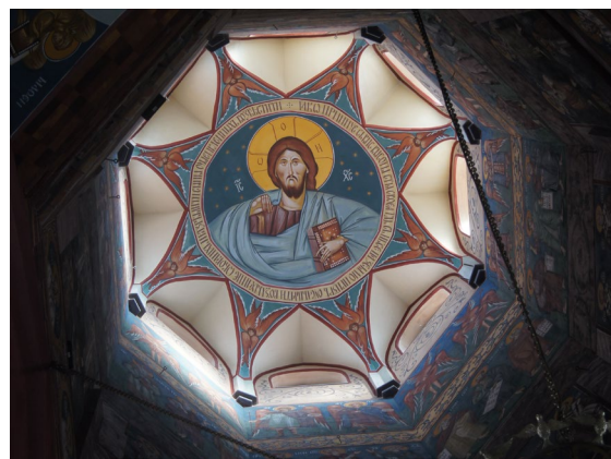
Il. 14. Supraśl. Cerkiew Zwiastowania Przenajświętszej Bogurodzicy. Widok sklepienia kopuły z lunetami po rekonstrukcji (fot. J. Uścińowicz, 2017)
