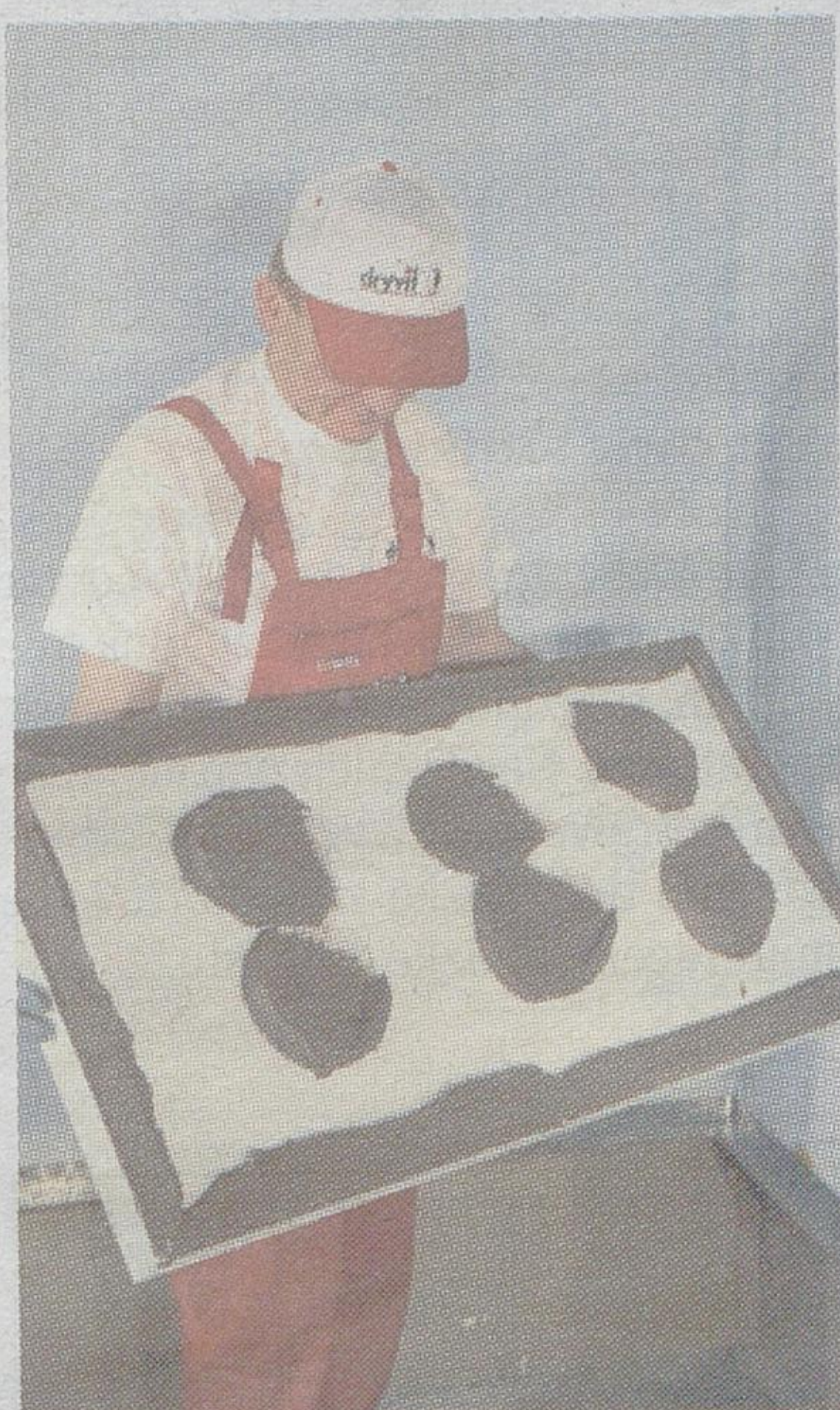
Najpopularniejszą metodą rozprowadzania zaprawy jest metoda „ramki i placzków”
