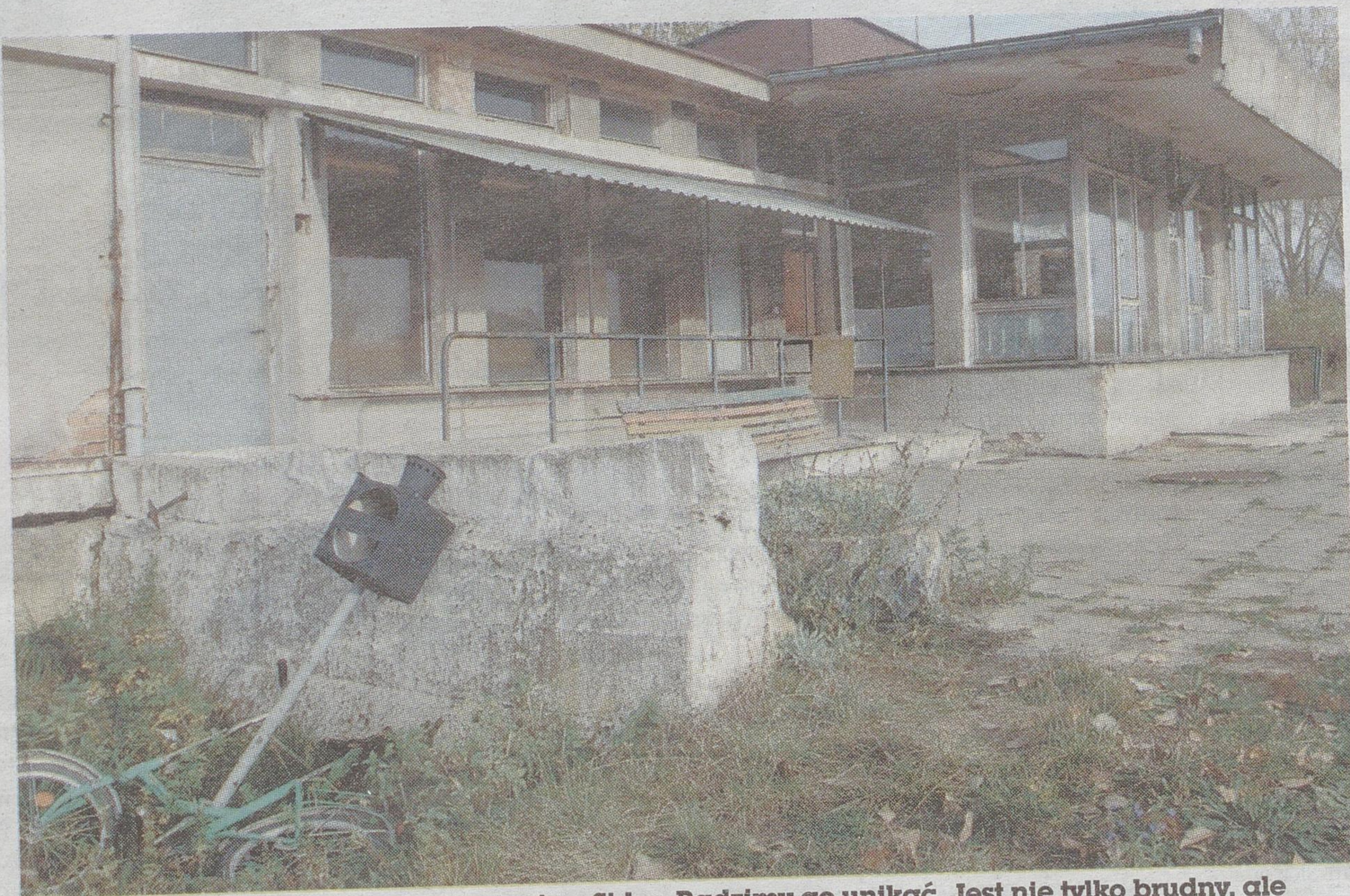
Najbrzydszy dworzec w naszym regionie – Siedlce. Radzimy go unikać. Jest nie tylko brudny, ale i w naprawdę fatalnym stanie technicznym.
