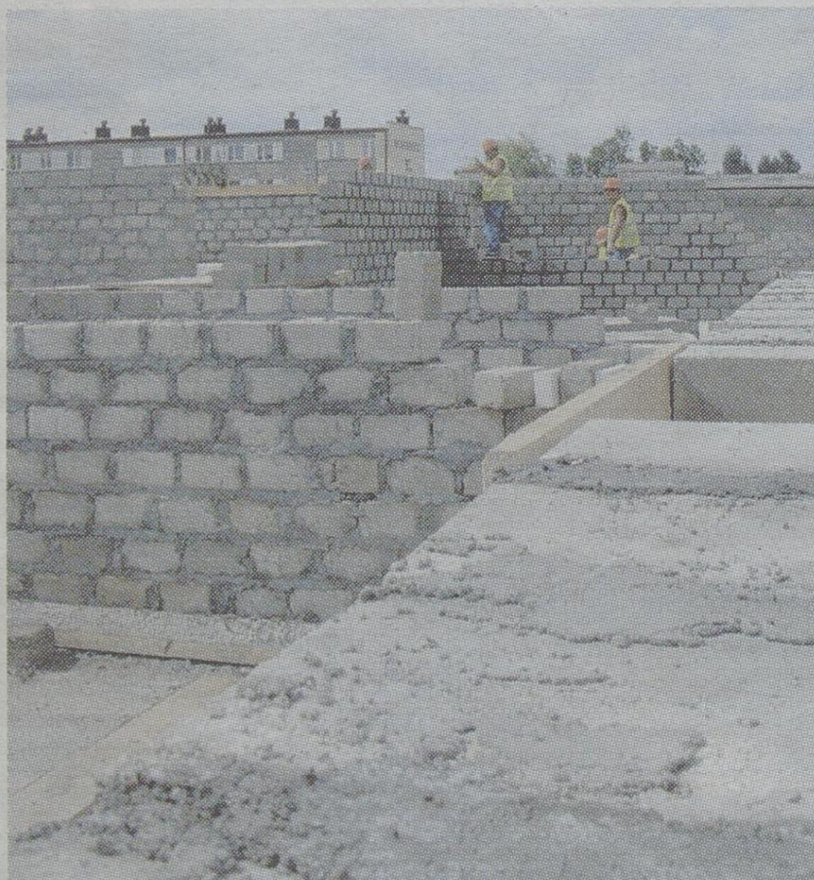
Obrazek z placu budowy na sokólskim osiedlu
