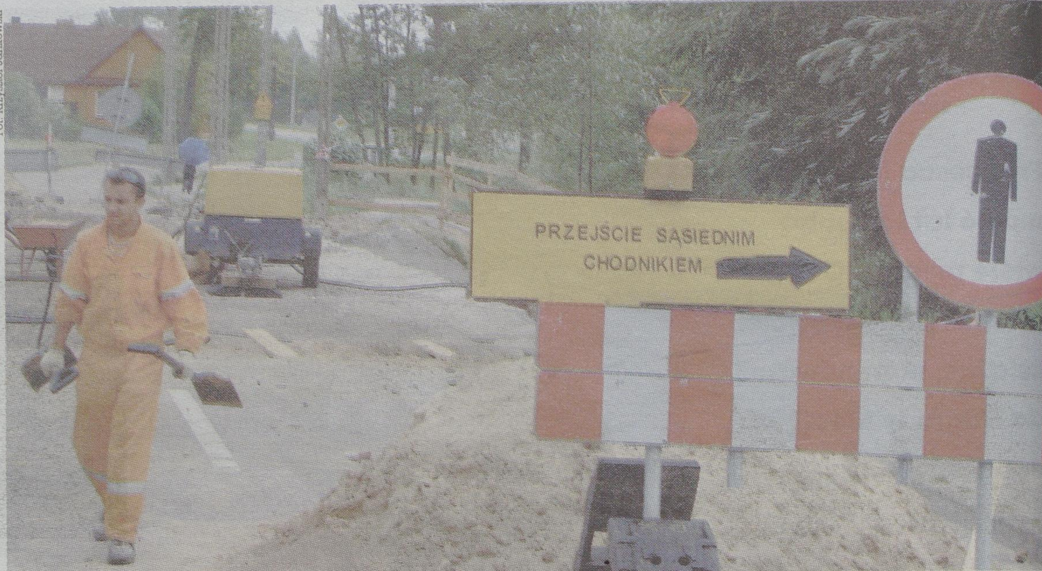
Do połowy listopada potrwać prace modernizacyjne na moście nad rzeką Białą na ul. Widowskiej. Wyremontowany most powinien posłużyć przez co najmniej 30 kolejnych lat.
