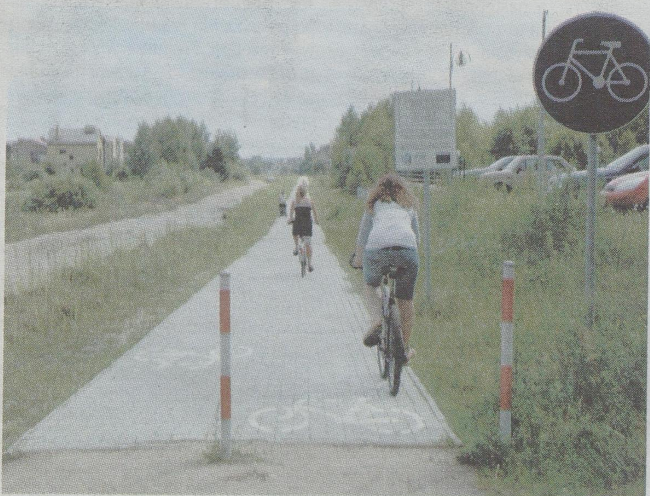
Rowerzyści mogą już jeździć po ścieżce na osiedlu Wygoda bez obawy, że będzie nią jechać samochód
