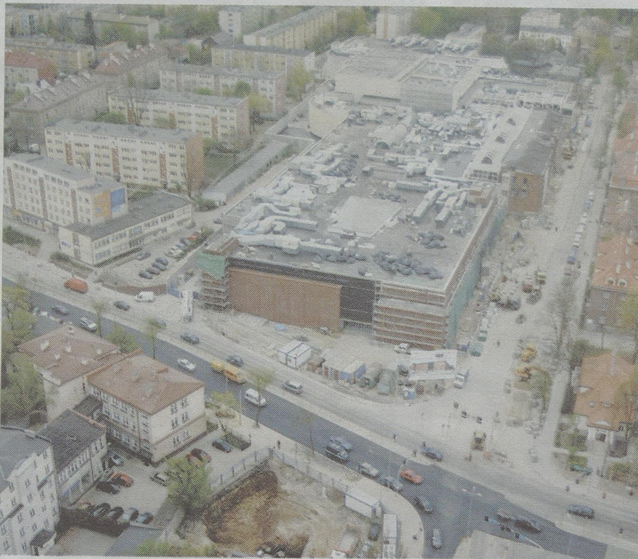
Widok na budowaną galerię handlową Alfa przy ul. Świętojańskiej. Na pierwszym planie ul. Mickiewicza.
