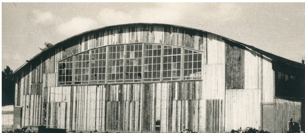
26. Szalunek wykonany w miejscu obcięcia hali targowej po poszerzeniu ul. M. Skłodowskiej-Curie w latach pięćdziesiątych XX w. Źródło: zbiory Tadeusza Chańki
