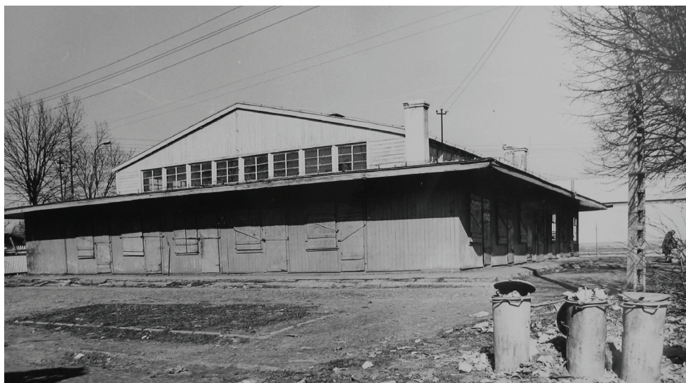
27. Hala targowa na Starym Rynku w latach siedemdziesiątych XX w. pozostawała pustostanem. Źródło: Wojewódzki Urząd Ochrony Zabytków w Białymstoku The market hall in the Stary Rynek remained empty in the 1970s. Source: Voivodeship Office for the Protection of Monuments in Białystok
