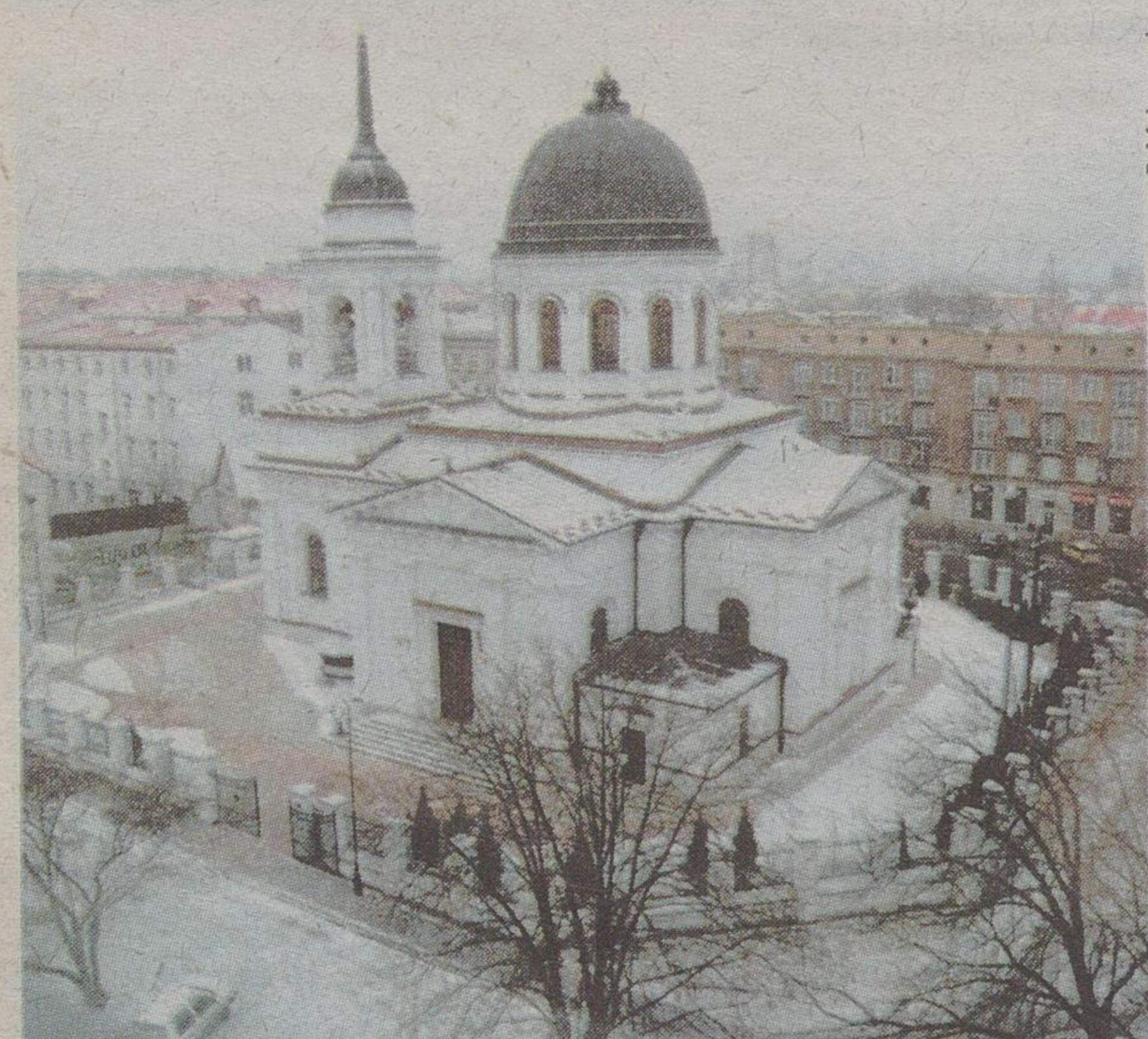
Na remont elewacji cerkwi św. Mikołaja z miejskiej kasy dołożono 70 tys. zł.
