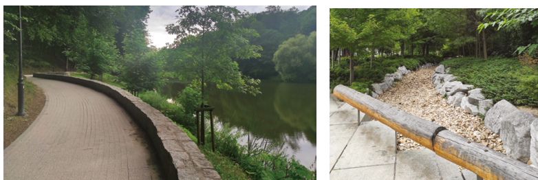
RYC. 4.10. Przykłady zabezpieczenia ciągu pieszego przed różnicami wysokości. Z lewej Gdańsk, z prawej Madryt (Hiszpania)
