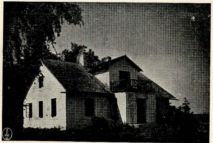
Budynek administracyjny lotniska Grodno—Karolin.
