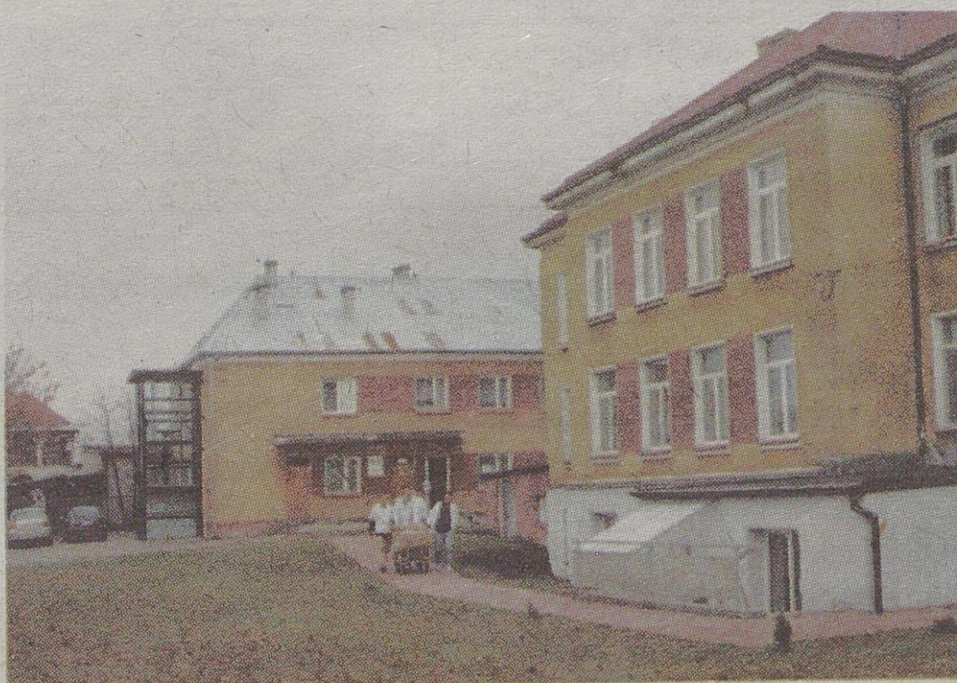
2007 rok był czasem szpitalnych inwestycji
