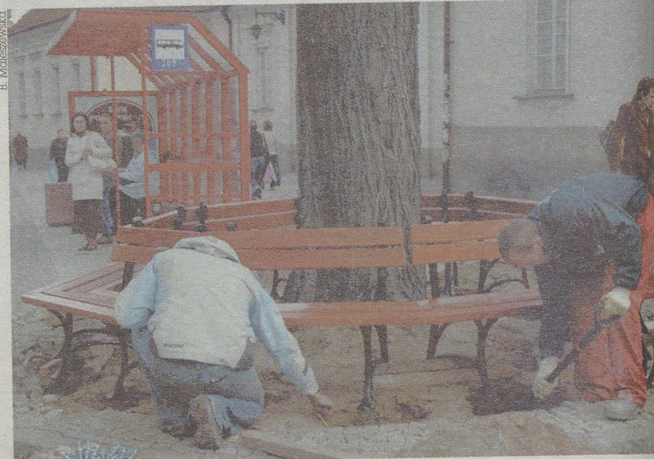
Trwają już ostatnie prace przed otwarciem placu miejskiego. Wczoraj ustawiano ławki wokół drzewa przy przystanku.
