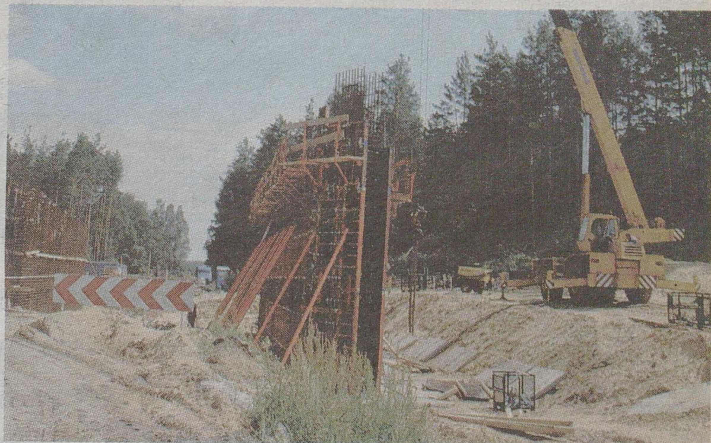
Budowa obwodnicy trwała od pół roku. Na zdjęciu powstający wiadukt w okolicach wsi Woroszyły.
