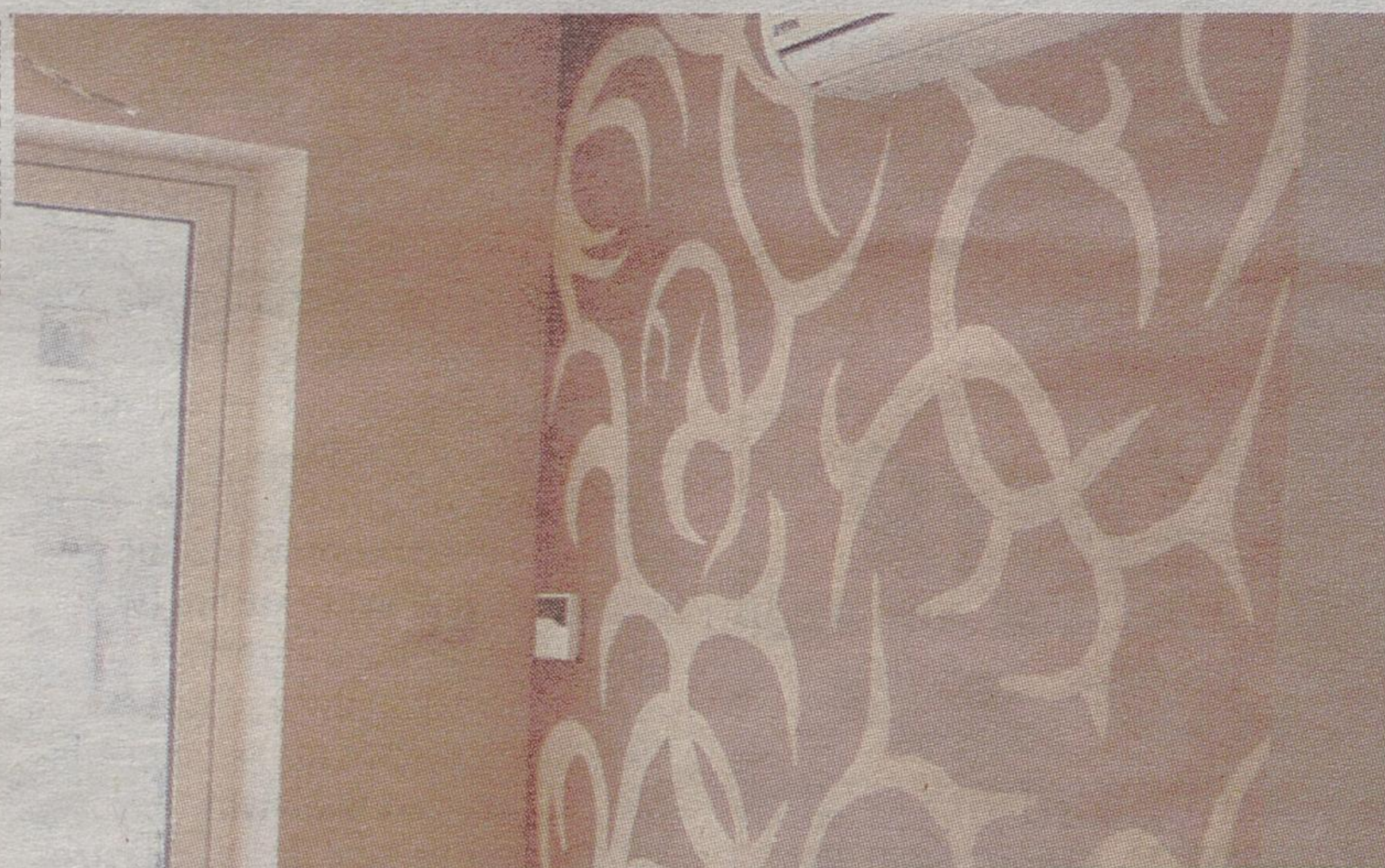
Tynk strukturalny akrylowy został pokryty najpierw ciemną farbą, a potem na niej namalowano jasne wzory
