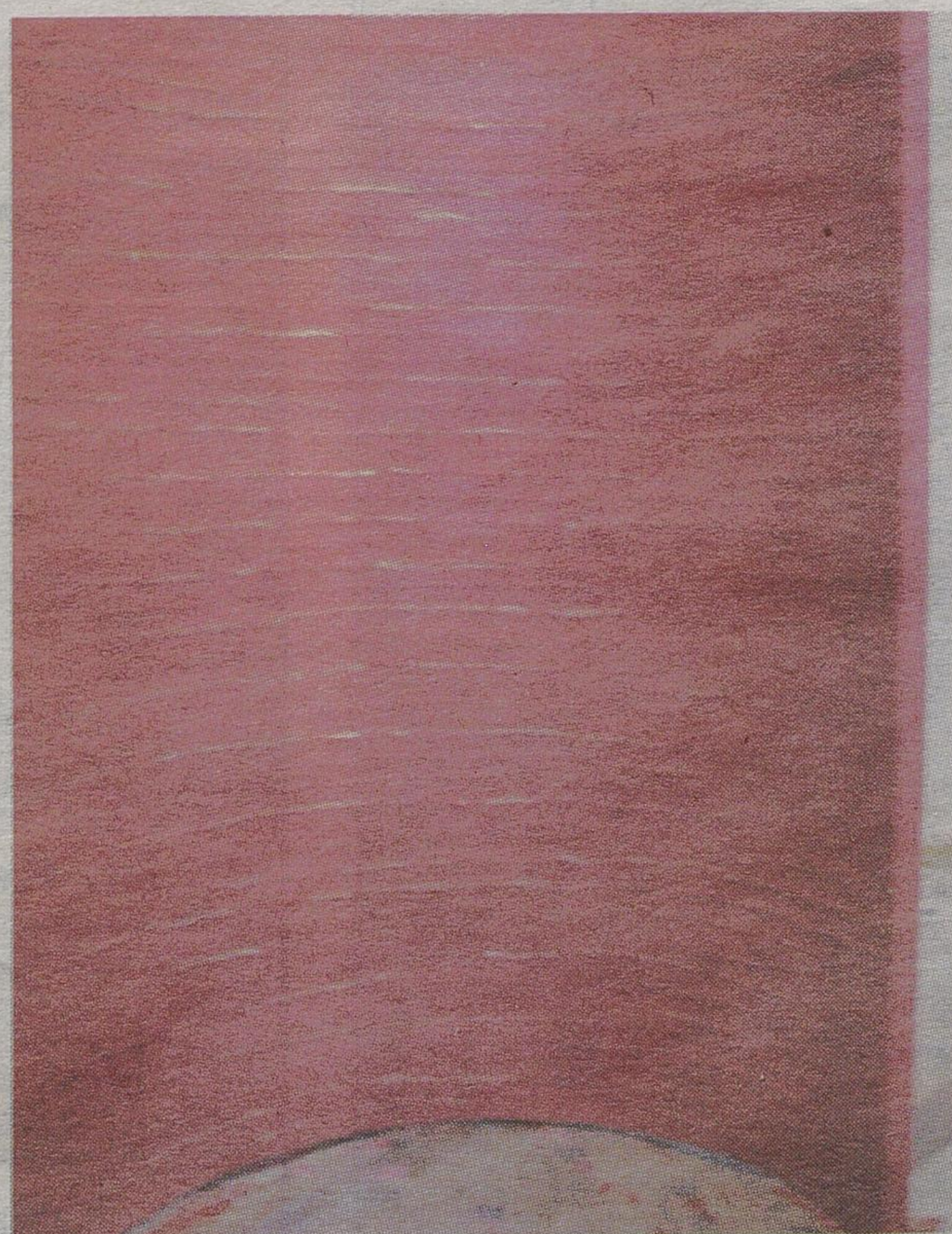
Akrylowy tynk strukturalny podkreślający odrębność jednej ze ścian
