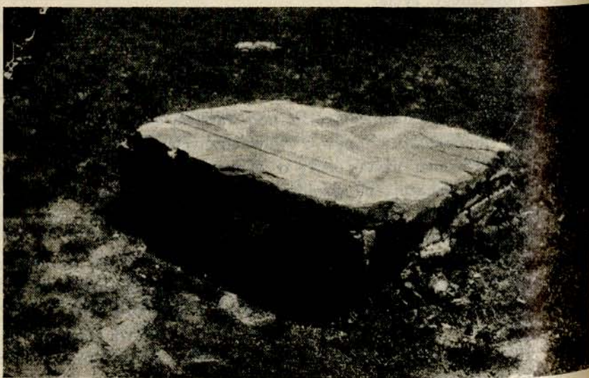
Ryc. 89. Cerkiew nad Ługiem. Fundament słupa.
