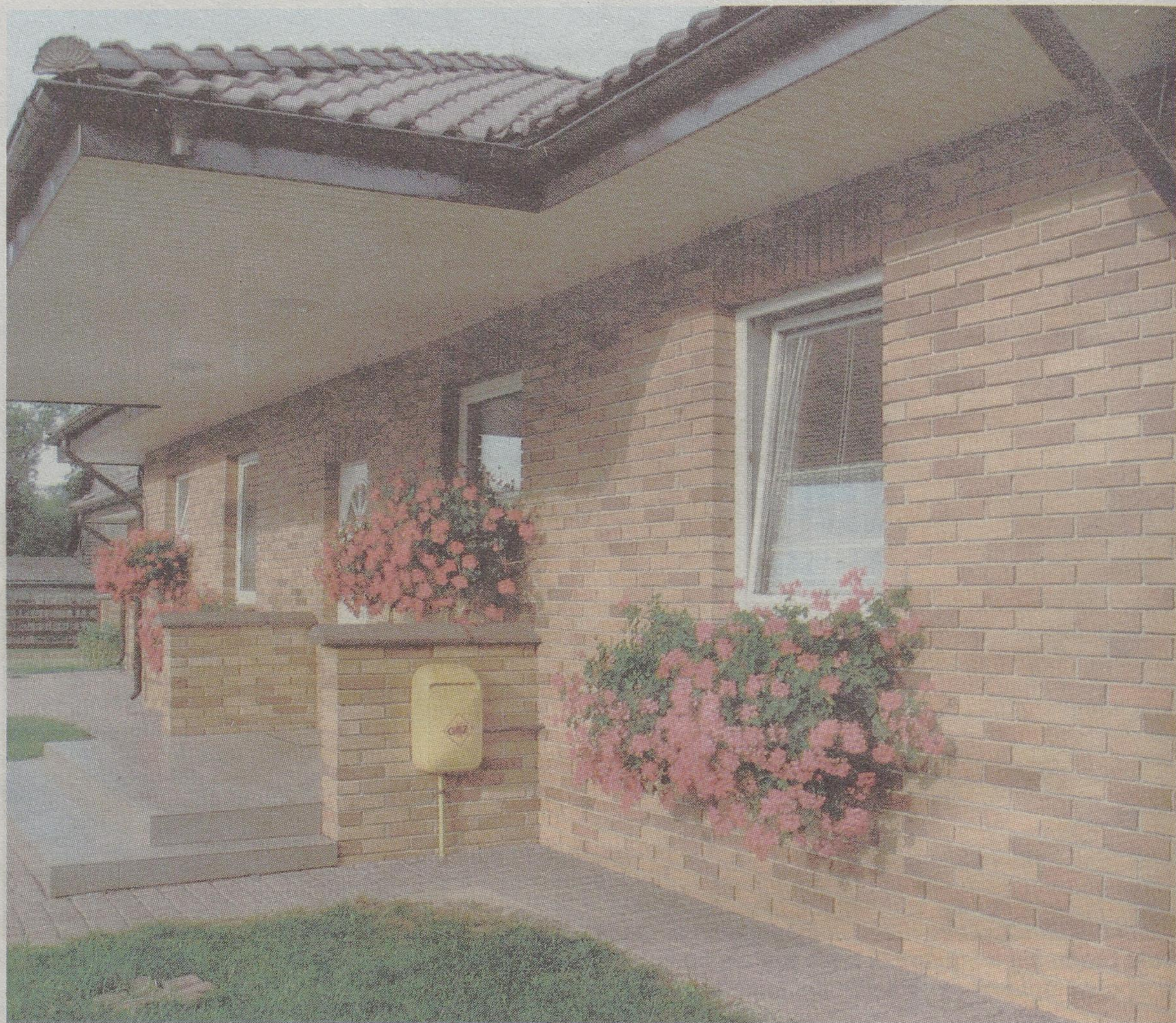
Elewacja z cegły klinkierowej. Mimo nie najniższej ceny, takie rozwiązanie cieszy się dużym powodzeniem, jako trwałe, praktyczne i bardzo estetyczne.
