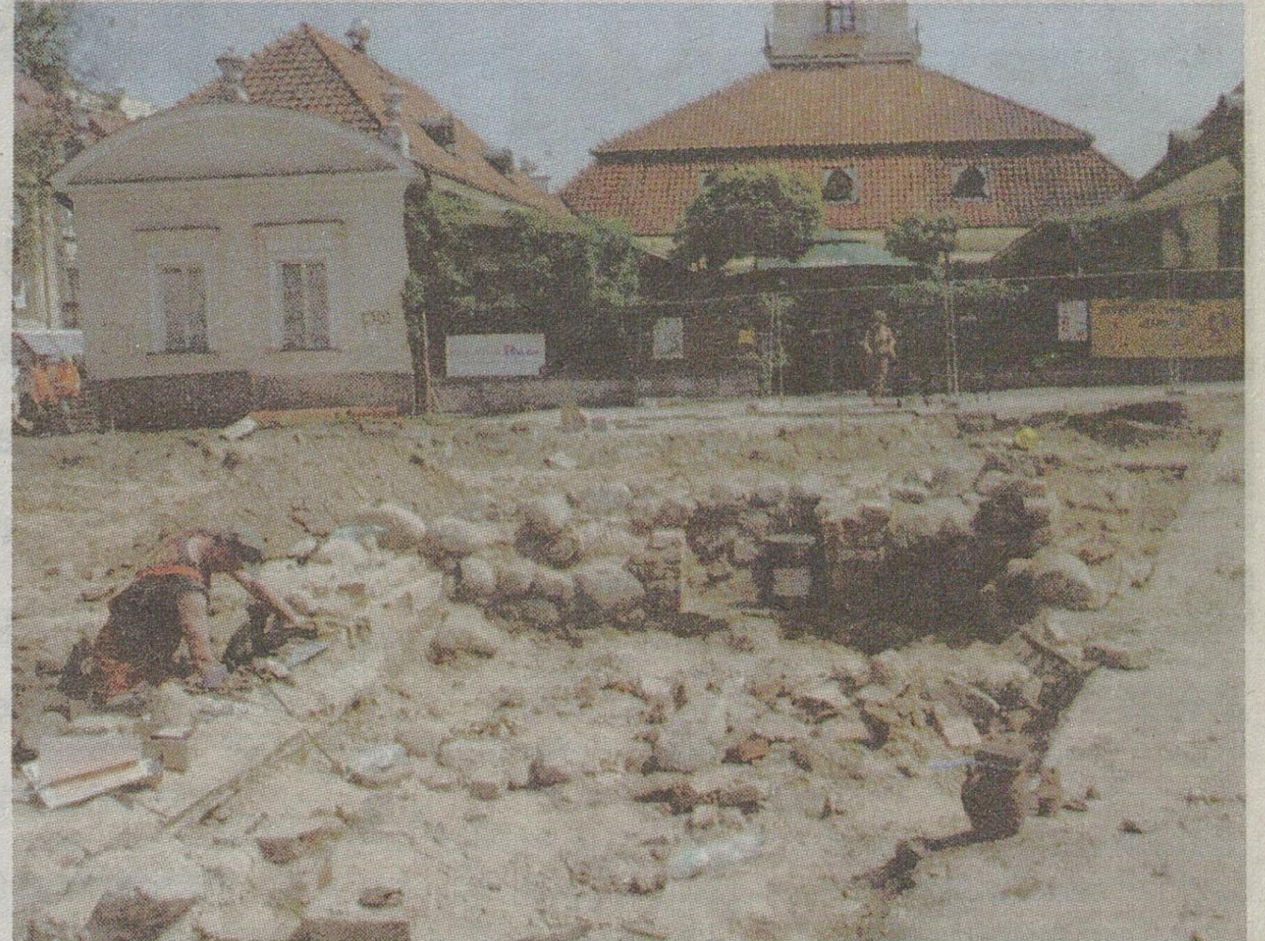
Już jesienią te kamienne fundamenty będziemy mogli zobaczyć w pełnej krasie – podświetlone i przykryte szybą.
