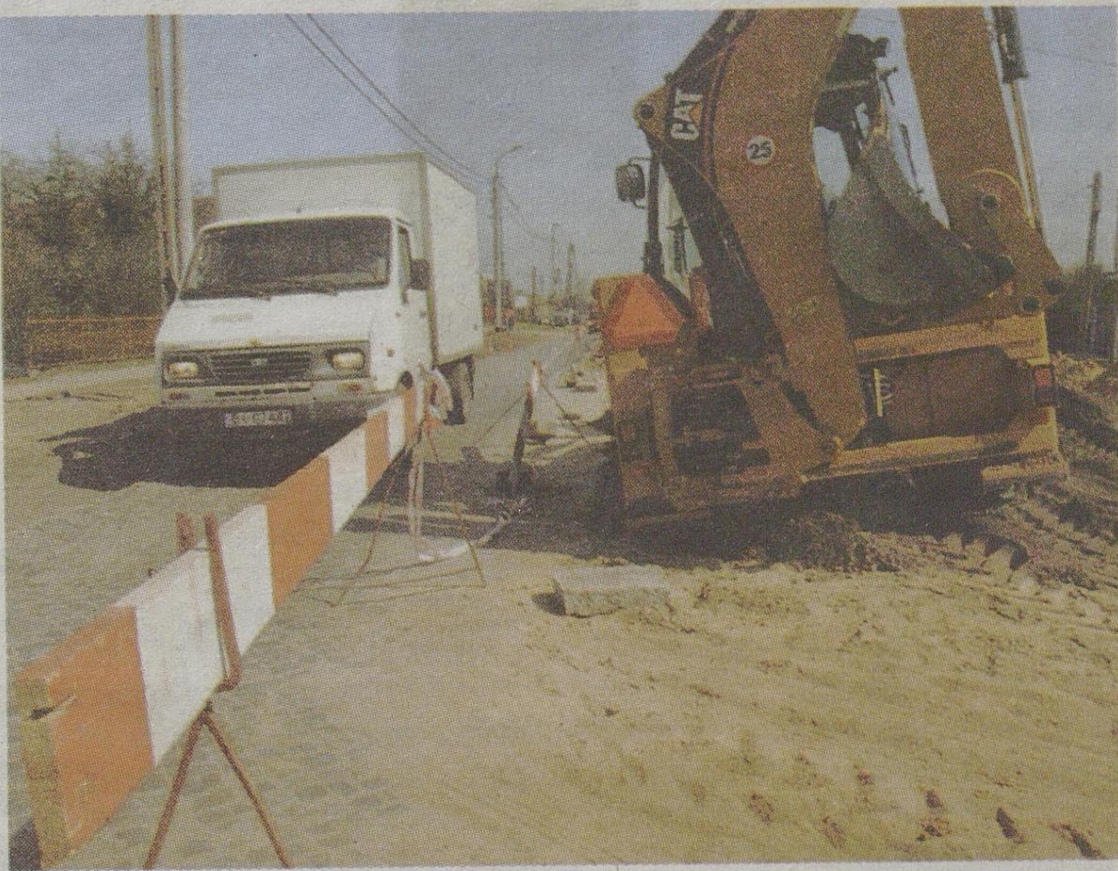
Drogowcy już od kilku tygodni prowadzą prace, ale poważne utrudnienia czekają nas od początku przyszłego tygodnia
