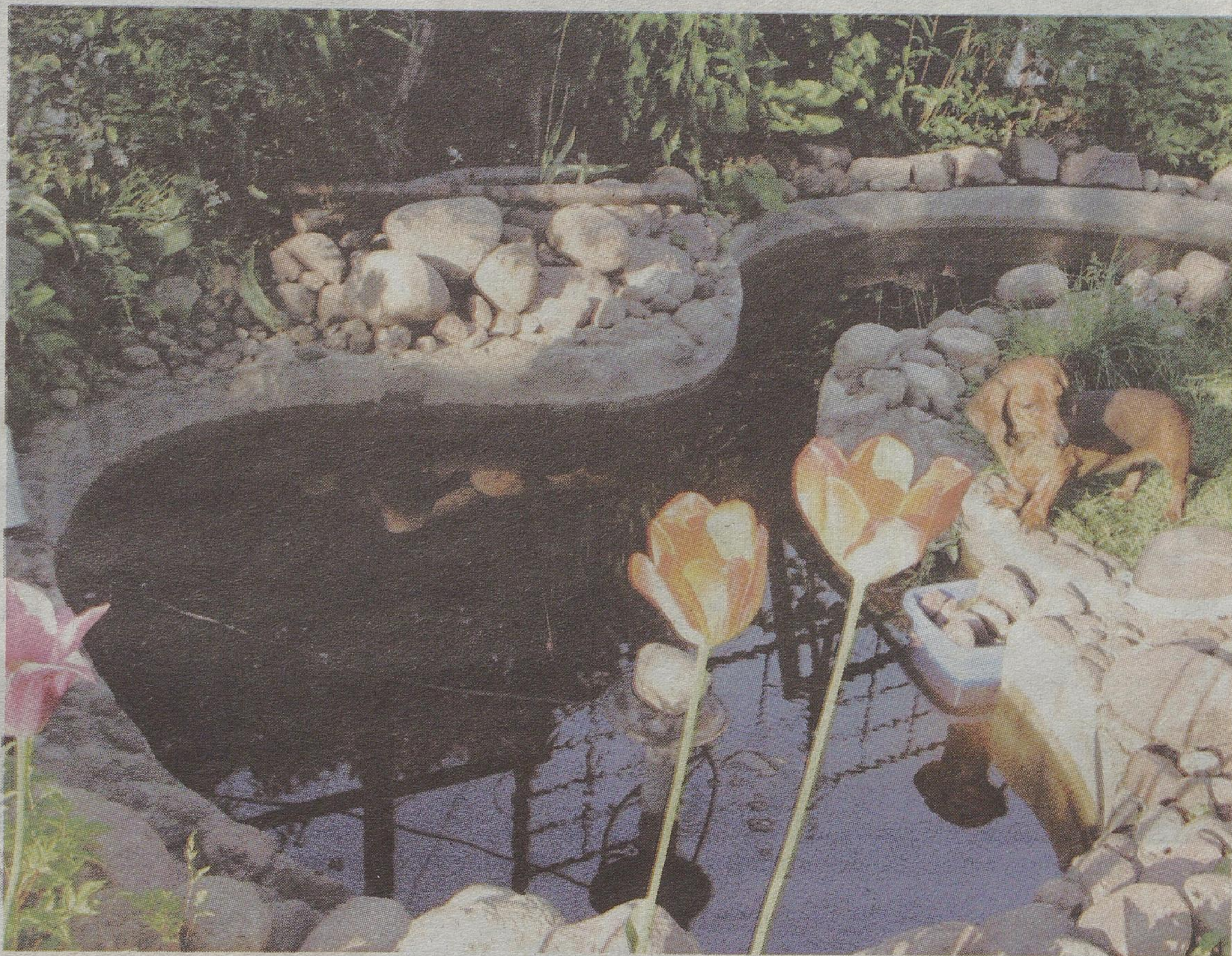
Wybetonowana niecka, brzegi obłożone kamieniami – dzisiaj dostępne są mniej pracochłonne technologie budowy oczka wodnego
