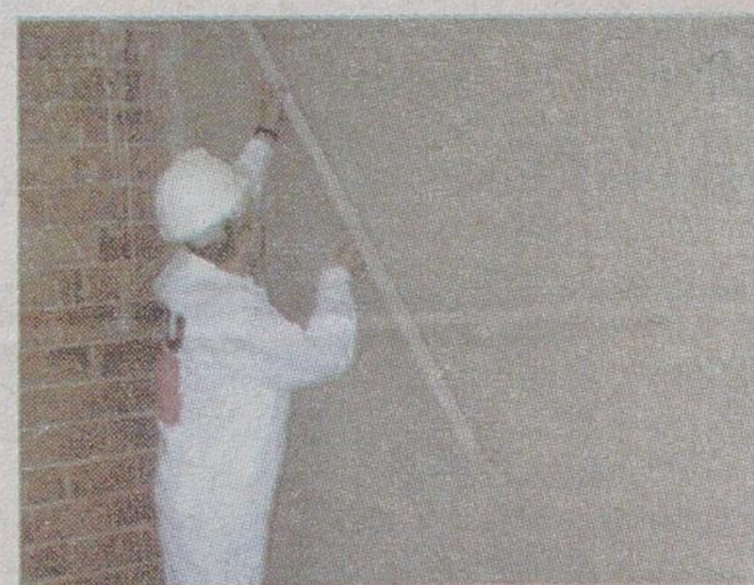
Nakładanie gotowej mieszanki tynkarskiej
