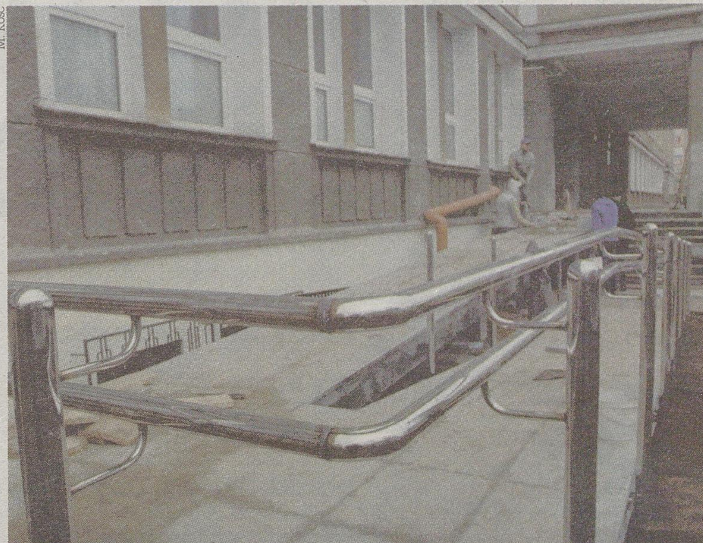
Jeszcze kilka dni temu niepełnosprawni byli do sądu wnoszeni. Niedługo będą mogli samodzielnie do budynku wjechać.
