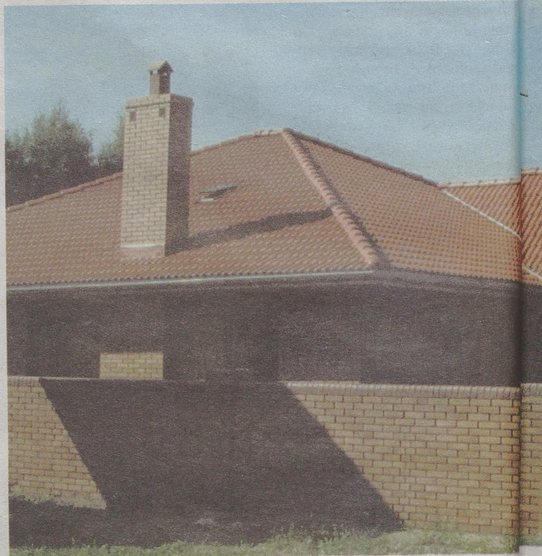
W willowych dzielnicach często spotykamy szczelny mur odgradzający posesję od otoczenia.
