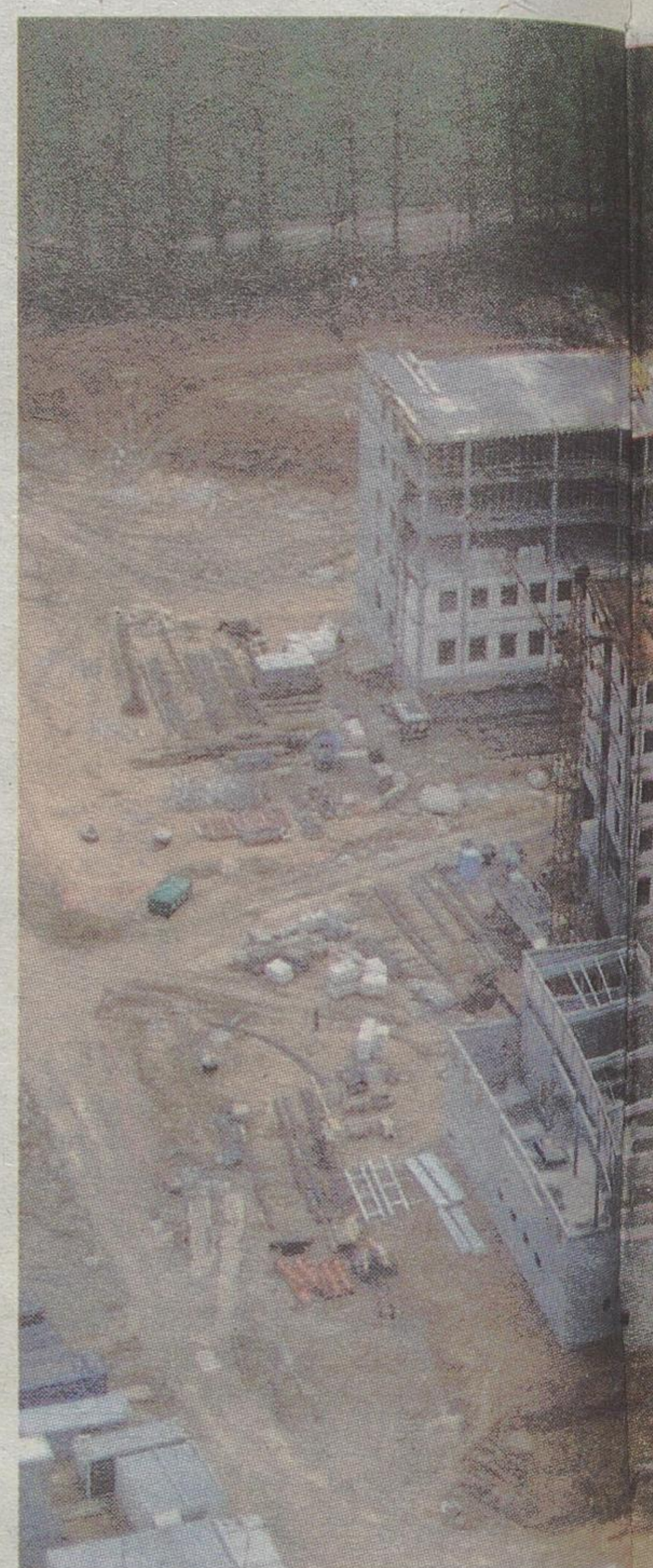
Widok na plac budowy z lotu budynków w obiekcie. Zdjęcie
