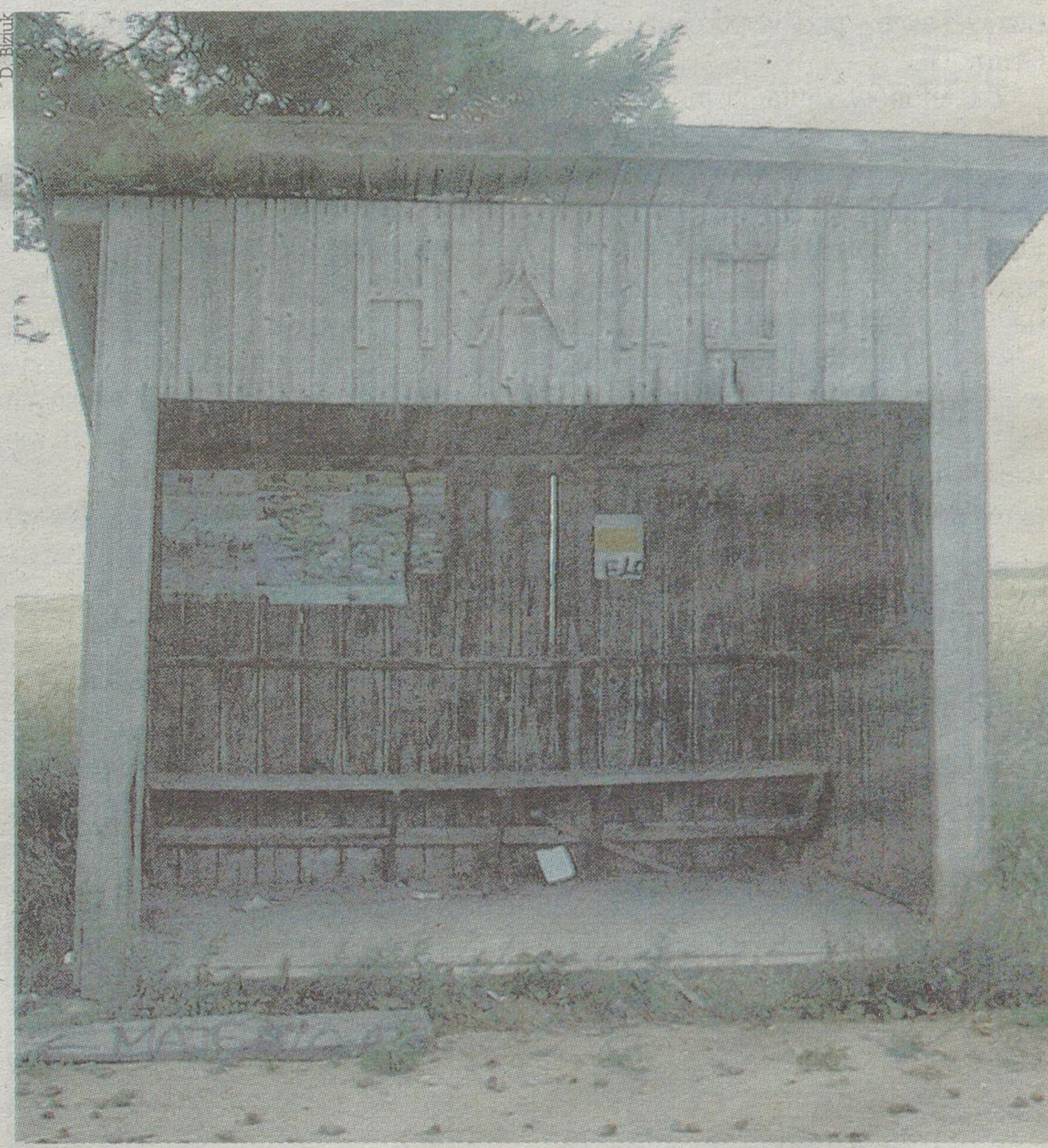
Deski, gwoździe i trochę wyobraźni – to wystarczy do wybudowania przystanku autobusowego. Okazuje się, że w XXI wieku w gminie Sokółka nie brakuje podobnych obiektów. Ten sfotografowaliśmy we wsi Hało. Równie archaiczny, jak powyższy przystanek, jest leżący przed nim kierunkowskaz do wsi Majewo.
