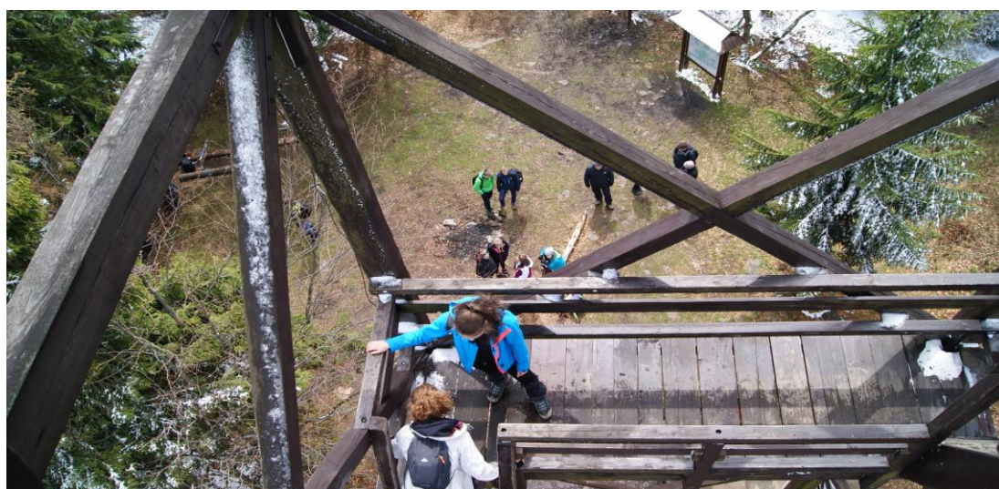
Wieża widokowa na Mogielicy – 1171 m n.p.m.
