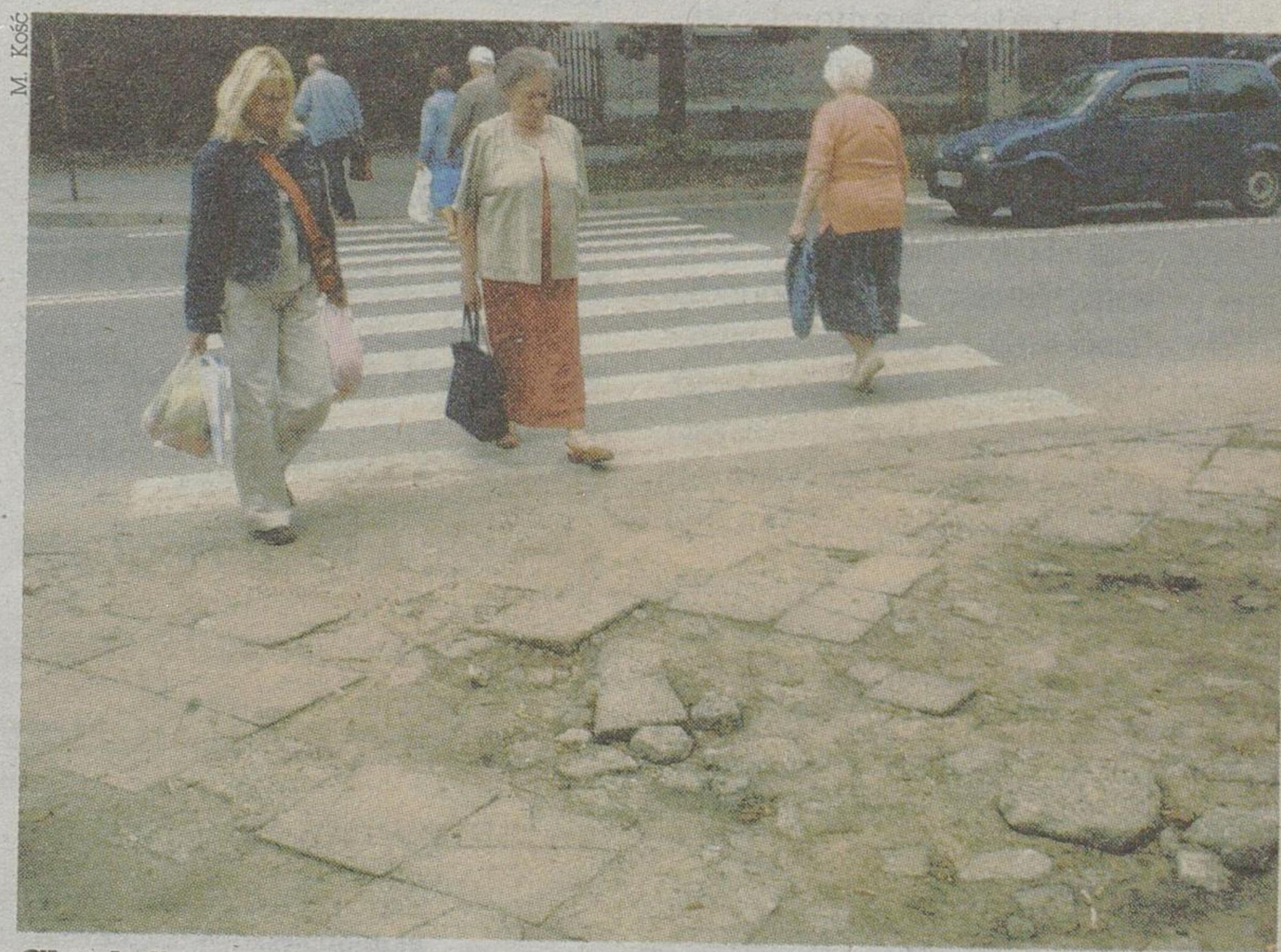
Chodnik w okolicach bazaru przy ulicy Jurowieckiej już od dawna wymaga remontu. Na szczęście zostanie wymieniony.
