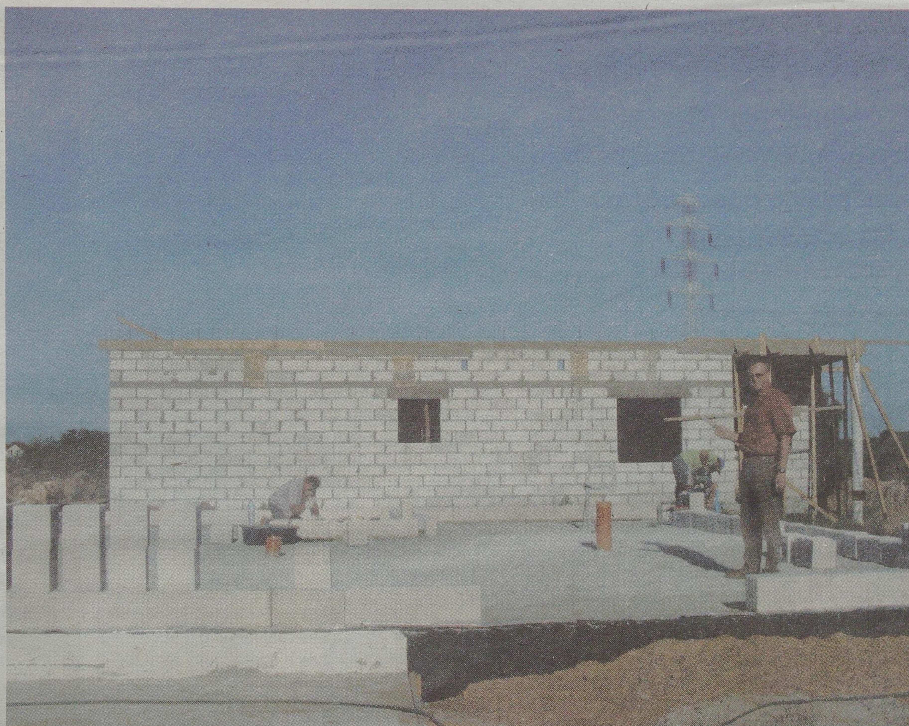
Już na początku budowa znacznie różni się od tradycyjnego domu. Dom został posadowiony na specjalnej płycie fundamentowej. Na pierwszym planie: Juwenal Gimer, właściciel na budowie.
