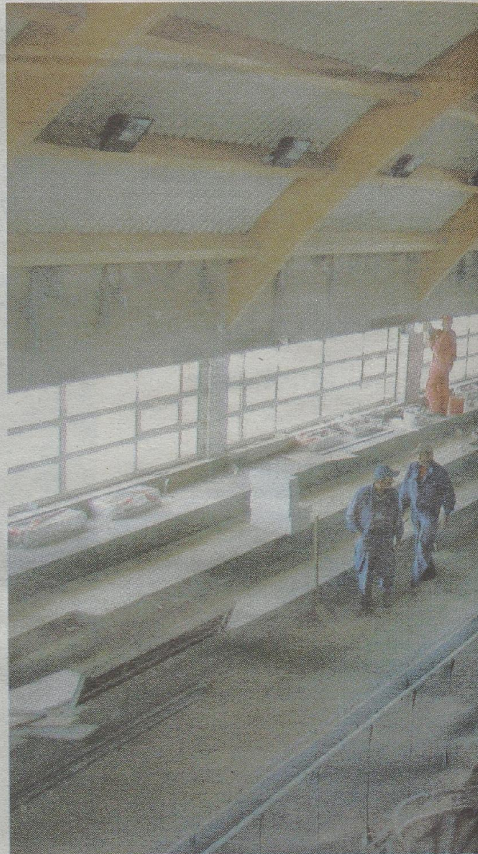
Niecka basenu zamiast zostać wyłożona gotowemu podłożu zostanie „wyścielona”
