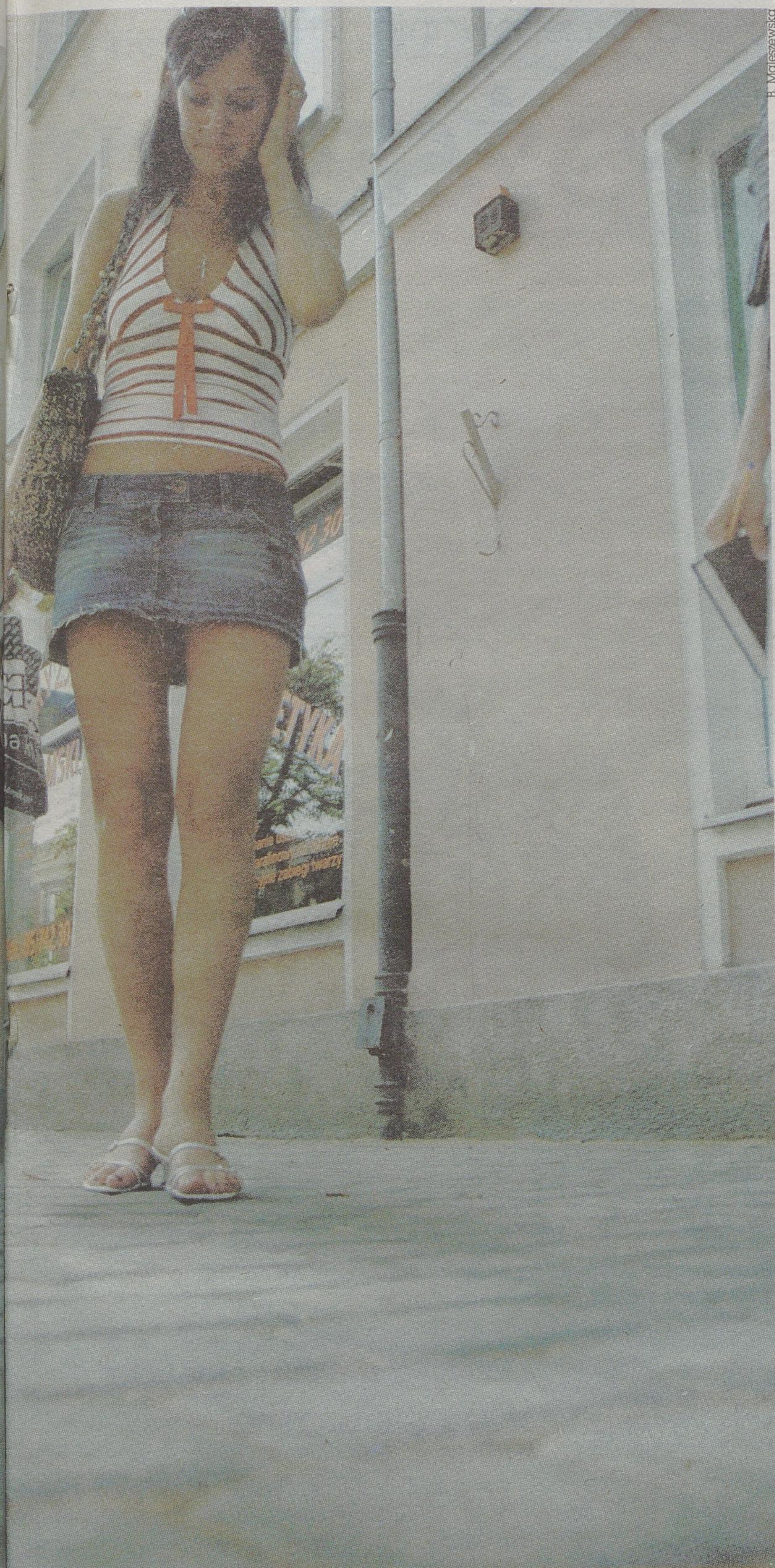
– Na tych chodniku przez chwilę nieuwagi można sobie skrócić nogę. Jest nierówny, a między kostkami są zbyt duże przerwy. Kto to w ogóle wymyślił? – pyta Ewa Borowik.
