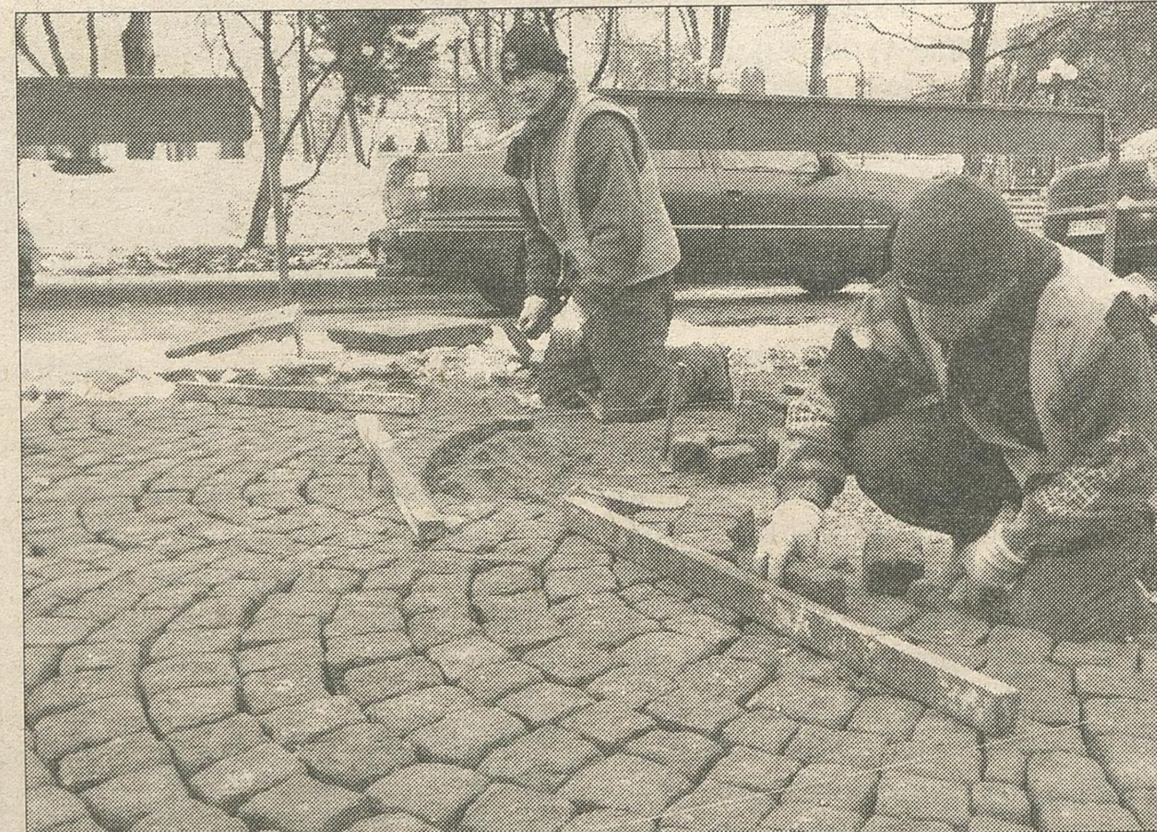
Pod koniec marca drogowcy wrócą na ulicę Liniarskiego i zaczną układać kostkę. Po sześciu tygodniach przeniosą się na drugi pas jezdni.
