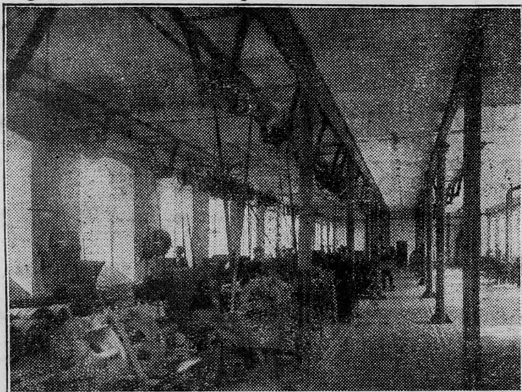
Fot. 3. Hala parterowa fabryki w stanie obecnym
