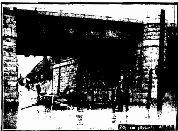
Wystarczył dwudniowy deszcz, aby pod wiaduktem kolejowym przy ul. Górcewskiej tak świetnie skanalizowanej, powstało jezioro, przez które przepływa jest naprawdę „przeprawa”.
