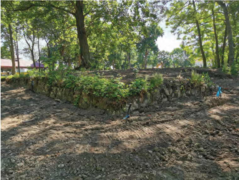
8. Zabłudów, pow. białostocki. Kamienny fundament dworu z 1622 r. od strony północno-zachodniej. Fot. L. Pawłata Zabłudów, Białystok County. The stone foundation of the manor from 1622 seen from the north-west side. Photo by L. Pawłata
