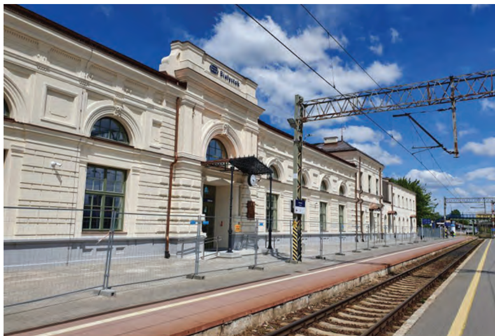
3. Dworzec PKP im. D. Siedzikówny w Białymstoku. Aktualny stan. Fot. PKP S.A. D. Siedzikówna PKP railway station in Białystok. Current state. Photo by PKP S.A.
