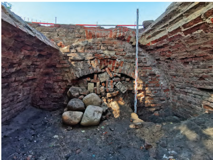
26. Zabłudów, pow. białostocki. Zachodnia ściana piwnicy. Fot. L. Pawlata Zabłudów, Białystok County. West wall of the basement. Photo by L. Pawlata
