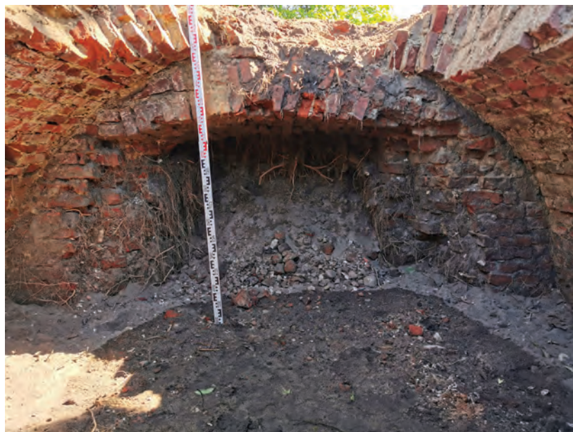
27. Zabłudów, pow. białostocki. Wschodnia ściana piwnicy. Fot. L. Pawlata Zabłudów, Białystok County. East wall of the basement. Photo by L. Pawlata
