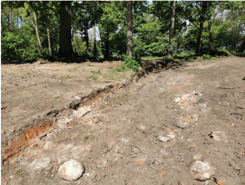
16. Zabłudów. Odślonięte lico fundamentu ściany fasadowej i kamiennej podbudowy schodów wejściowych dworu z 1622 r. Fot. L. Pawlata Zabłudów. The exposed face of the façade wall's foundation and the stone foundation of the entrance stairs to the manor from 1622. Photo by L. Pawlata
