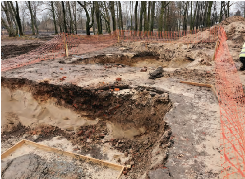
17. Zabłudów, pow. białostocki. Przekrój zasypiska usuniętego fundamentu ściany zachodniej „Domu dla przyjezdnych”. Fot. L. Pawlata Zabłudów, Białystok County. Cross-section of the backfill of the „guest house” western wall's removed foundation. Photo by L. Pawlata
