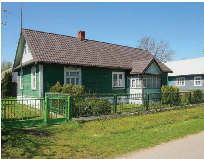
12. Plutycze. Zagroda 113. Fot. A. Kułak, 2021 Plutycze. The homestead 113. Photo by A. Kułak, 2021
