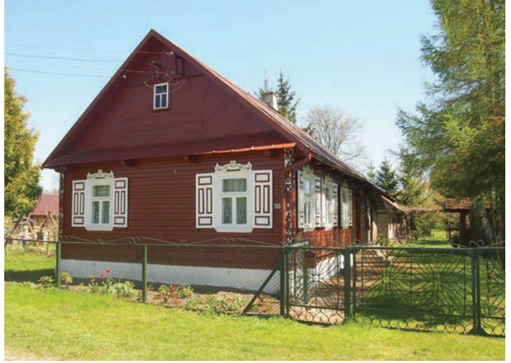
13. Plutycze. Zagroda 118. Fot. A. Kułak, 2021 Plutycze. The homestead 118. Photo by A. Kułak, 2021
