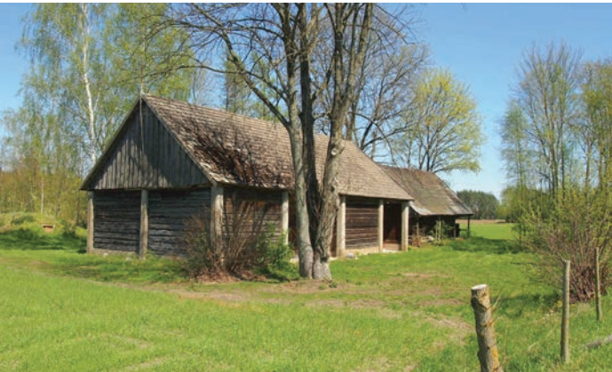
22. Plutycze. Budynki gospodarcze. Fot. I. Górską, 2021 Plutycze. Farm buildings. Photo by I. Górską, 2021
