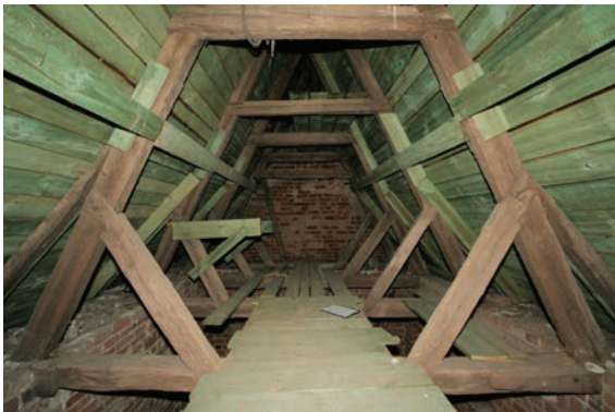
16. Widok więźby wieży-dzwonnicy kościoła w Szczepankowie. Fot. M. Warchoł View of rafter framing of the tower-belfry of the church in Szczepankowo. Photo by M. Warchoł
