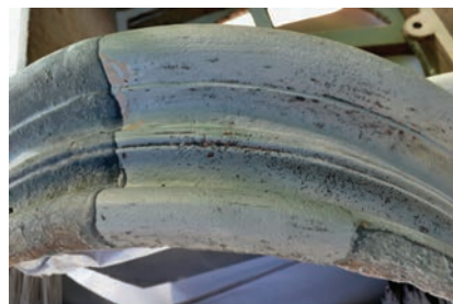
10. Pomnik Joachima Litawora Chreptowicza w Sztabinie, detal, stan w trakcie konserwacji. Oczyszczanie powierzchni metalu metodą strumieniowo-ścierną.
