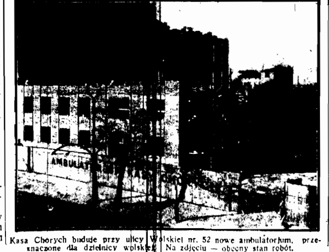
Kasa Chorych buduje przy ulicy Wolskiej nr. 52 nowe ambulatorium, przeznaczone dla dzielnicy wolskiej. Na zdjęciu — obecny stan robót.
