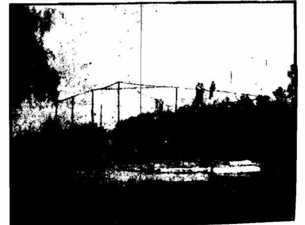
Na terenie powstającego Ogrodu Zoologicznego (za parkiem Pragskim) wre ożywiona praca. Przed zimą bowiem musi nastąpić przeprowadzka czworonogich i skrzydlatych mieszkańców z Alei 3-go Maja na Pragę. Na fotografii montowanie dużej klatki siatkowej.
