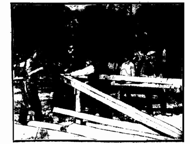
W szybkim tempie pracują liczni robotnicy wydziału technicznego Magistratu nad budową pawilonów i klatek w przeniesionym na Pragę zwierzynca warszawskim.
