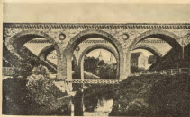
Wielki most nad Łyną w Ostrołęce
