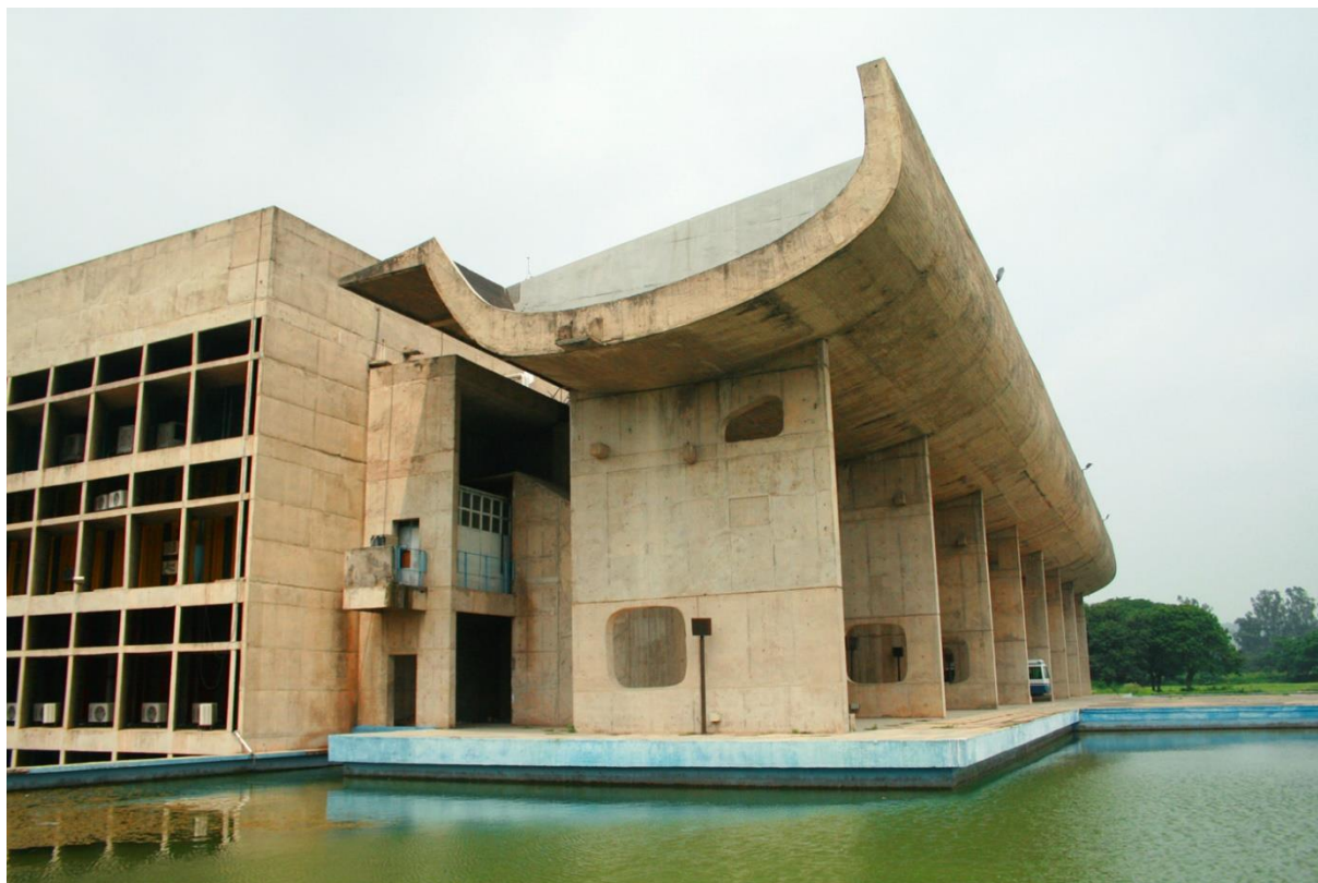
Obraz 6. Le Corbusier. Pałac Chandigarh - sekretariat, 1953, przykład rzeźbiarskiego wykorzystania betonu, Źródło: [F]
