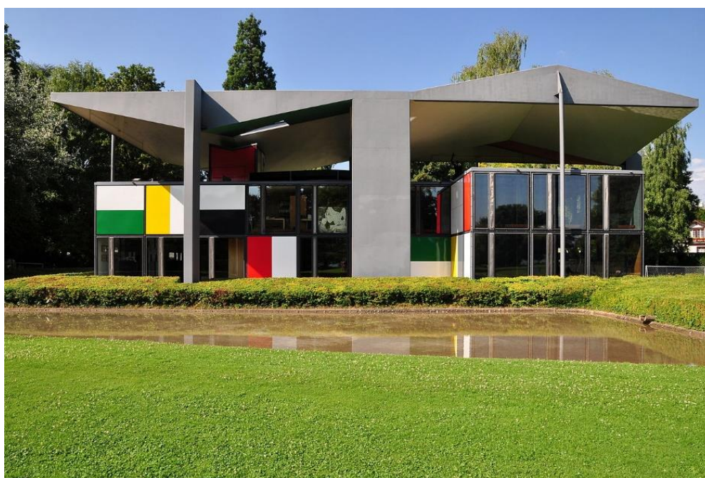
Obraz 7. Le Corbusier. Muzeum Heidi Weber w Zurichu (1967). Muzeum sztuki współczesnej to ostatni budynek wielkiego architekta, a zarazem nowatorski, lekki obiekt wykonany ze stali i szkła. Do montażu wykorzystano 20 tysięcy śrub, Źródło:[G]
