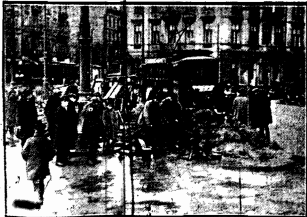
Pod jezdnią na placu Zbawiciela widać onegdaj poważnemu uszkodzeniu magla elektryczna tura wodociągowa. Naprawa spowodowała ograniczenie ruchu kołowego i zmianę rozkładu jazdy tramwajów.
