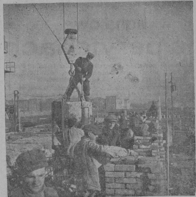
Coraz więcej nowoczesnych mieszkań przybywa na osiedlu A-31 w Nowej Hucie. Osiedle A-31 budowane jest metodą kompleksową. Stosuje się tu potokowy system budowy oraz elementy prefabrykowane jak stropy, schody, przedproża itp.
