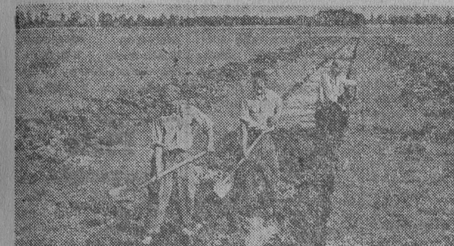
Dzięki wydatnej pomocy państwa i ofiarności mas chłopów trwają na terenie całego kraju prace nad oczyszczaniem, konserwacją i budową urządzeń wodno-melioracyjnych.
