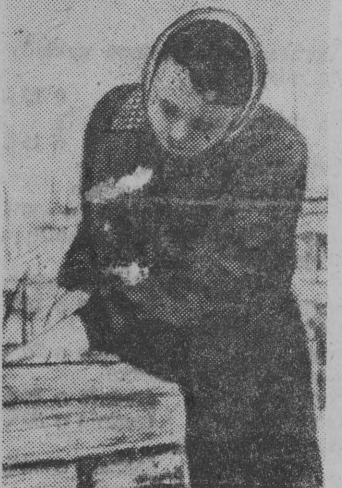
Córka 3-hektarowego chłopca z Hajnówki, zelanpówka Mariusza Oniszczuk pełni Wartę Pierwszomajową przy zagospodarowywaniu placu pod budowę kombinatu bawelnianego w Fastach.
