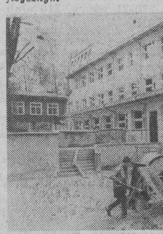
Tak wygląda nowy obiekt szkolny. W pracach wykończonych przy budowie pomagali uczniowie.
