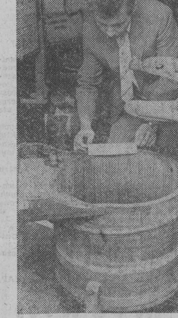
W tzw. stopę fundamentową w pierwszym budynku nowej mleczarni wmurowano akt erekcyjny.
