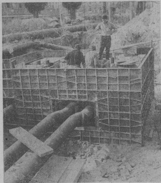
Ta zmodernizowana komora ciepłownicza przyczyni się m.in. do lepszego ogrzania szpitali znajdujących się w okolicach ul. KRASIŃSKIEGO w Białymstoku. Fot. ZDZISŁAW LENKIEWICZ
