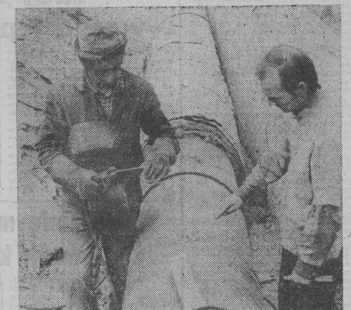
Zygmunt Małyszko i Sławomir Adamski „kładą” ostatni spaw na rurociągu przy ul. Jurowieckiej w Białymstoku.
