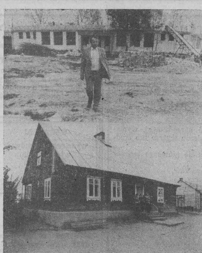
Na zdjęciach: dwie szkoły w Niedźwiedź – nowa w budowie.
