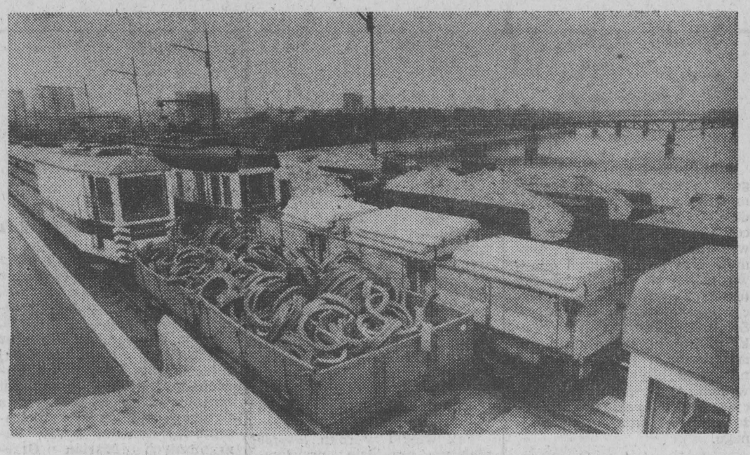
Na warszawskim Moście Poniatowskiego przeprowadzone były próby obciążeniowe poszczególnych osi mostu. Każde z nich obciążano było 12 lub 16 załadowanymi samochodami ciężarowymi CAF—Janusz Mazur
