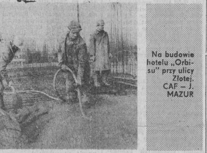
Na budowie hotelu „Orbis” przy ulicy Złotej. CAF — J. MAZUR
