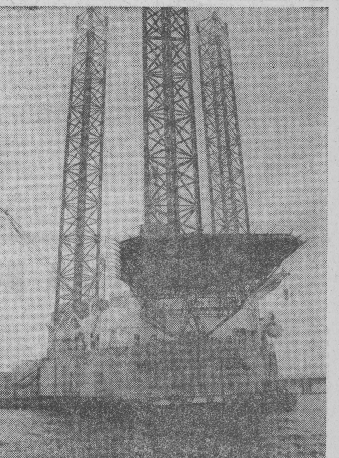
Sluząca do poszukiwań ropy naftowej i gazu na Bałtyku platforma wiertnicza „Petroaltica” na okres zimy została przyholowana do Portu Północnego w Gdańsku na przegląd urządzeń technicznych i instalacji. Na zdjęciu: wieża wiertnicza „Petroaltica” na czas remontu połączona została z lądem przez wybudowaną specjalnie konstrukcję stalową. CAF — Janusz Ukłajewski
