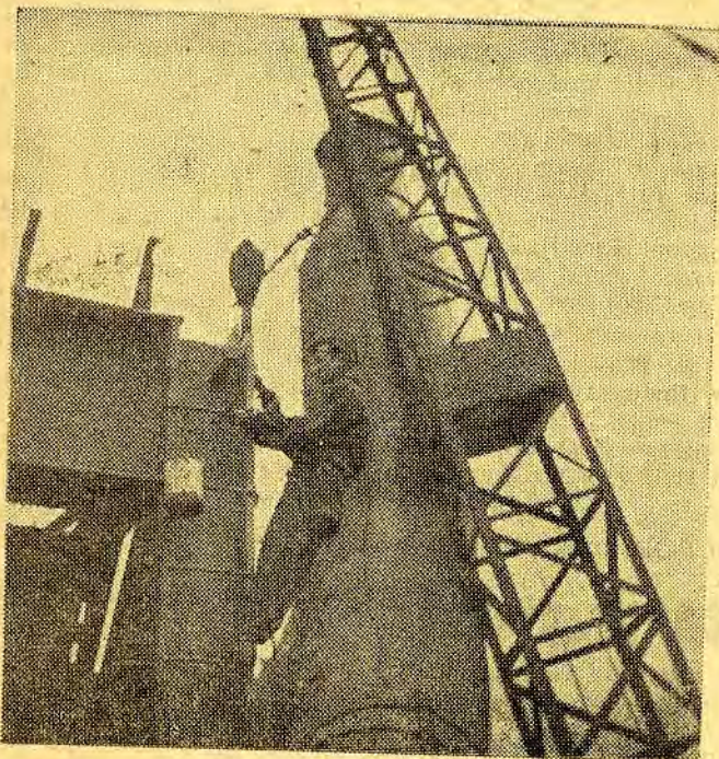
Wielki piec „C” w hucie „Kościusko”, największy obiekt wielkopieczowy w Polsce, stanowiący wyraz najnowszych zdobyczy techniki.
