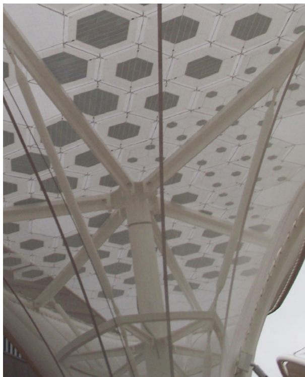
Ryc. 4. Pozyskiwanie energii słonecznej i biologicznej przy pomocy konstrukcji pawilonów: 4.1. Pawilon – pergola do pozyskiwania energii biologicznej; 4.2. Pawilon niemiecki – panele fotowoltaiczne nadrukowane na „kielichy – drzewa”; 4.3. Pawilon belgijski – ogniwa fotowoltaiczne przymocowane do szklanych ścian, daszki, również pełniące rolę żaluzji; źródło: fot. autorka
