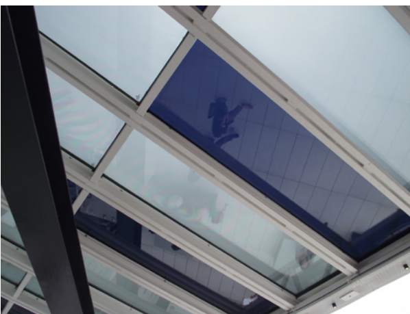
Ryc. 3. Inne materiały: 3.1. Pawilon chiński – zastosowanie ceramicznych, geometrycznych paneli samoczyszczących; 3.2. Pawilon włoski – na elewacji okładzina z oczyszczającą atmosferę betonu; 3.3. Pawilon amerykański – szklane zadaszenie pełniące rolę żaluzji zmieniających kolor; źródło: fot. autorka Fig. 3. Other materials: 3.1. Chinese pavilion - use ceramic, geometric panels self-cleaning; 3.2. Italian Pavilion - for the facade cladding of purifying the atmosphere of concrete; 3.3. American Pavilion - glass roof to act as shutters changing color; source: photo by the author
