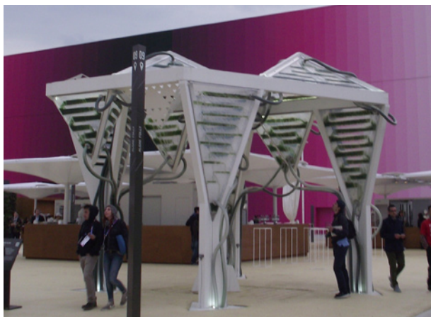
Ryc. 4. Pozyskiwanie energii słonecznej i biologicznej przy pomocy konstrukcji pawilonów: 4.1. Pawilon – pergola do pozyskiwania energii biologicznej; 4.2. Pawilon niemiecki – panele fotowoltaiczne nadrukowane na „kielichy – drzewa”; 4.3. Pawilon belgijski – ogniwa fotowoltaiczne przymocowane do szklanych ścian, daszki, również pełniące rolę żaluzji; źródło: fot. autorka
